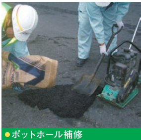
●ポットホール補修
