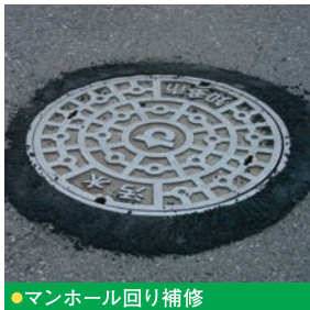
●マンホール回り補修
